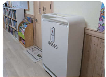
유치원 5대 설치
