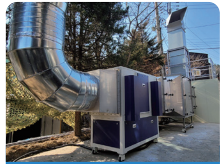
남양주시 직화구이 식당 설치
